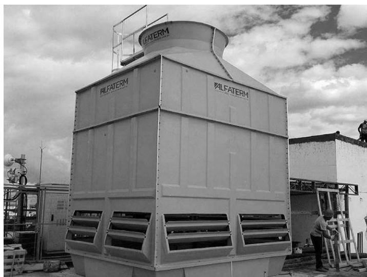
Figura 6 - Torre de Resfriamento. Fonte: http://www.alfaterm.com.br/torre-resfriamento-ar-condicionado
